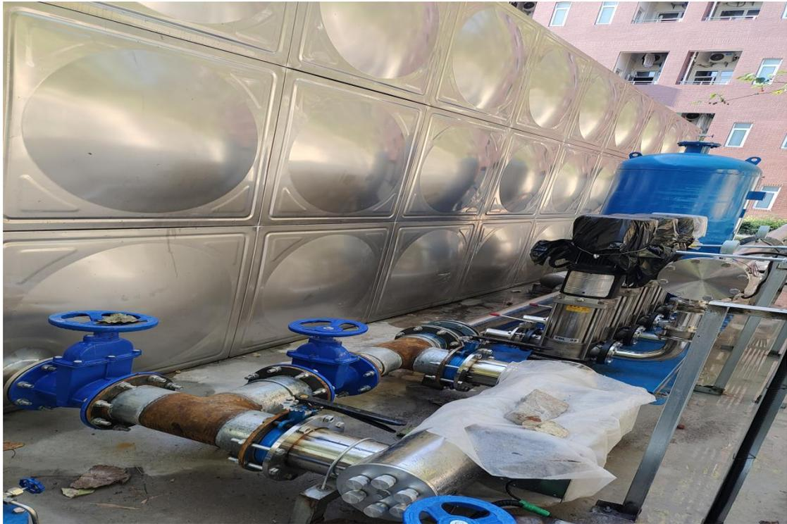
图 10 新建自来水加压站
